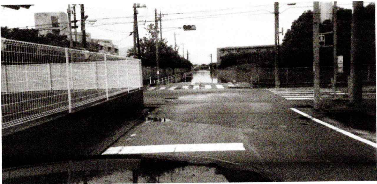
⑨ 大增中学校・勝彩園付近の冠水
